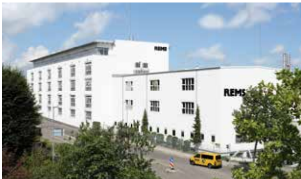
REMS Schulungszentrum in Waiblingen bei Stuttgart.
